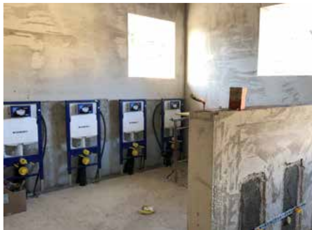
La posa dei servizi sanitari di un bagno dei bambini.
