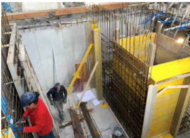
A sinistra l'esecuzione delle pareti del corpo dell'ascensore al piano seminterrato. A destra durante il getto della soletta del piano terreno.
