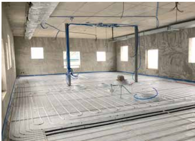
La posa delle serpentine nel pavimento al primo piano.
