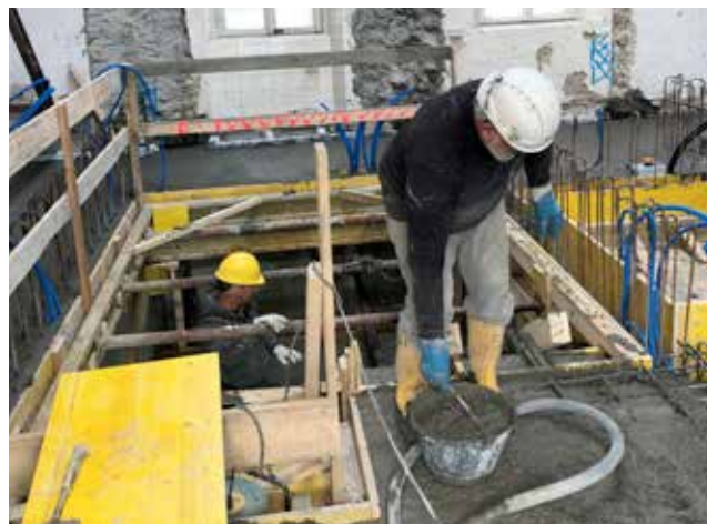
A sinistra l'esecuzione delle pareti del corpo dell'ascensore al piano seminterrato. A destra durante il getto della soletta del piano terreno.
